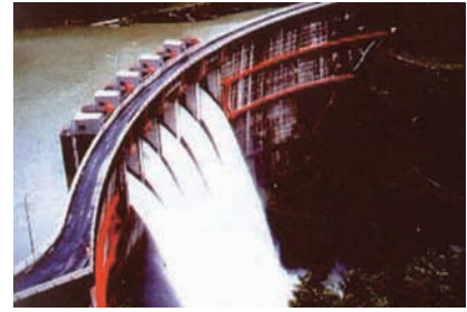
大迫アーチダム
