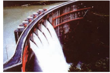
大迫アーチダム
