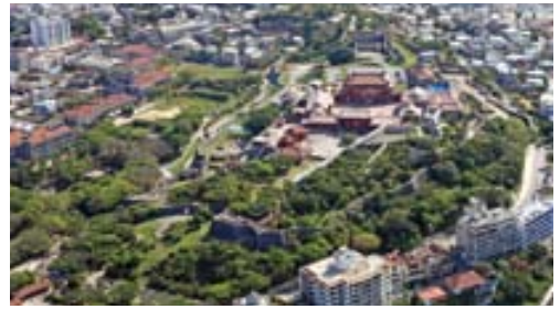
首里城公園 第2次世界大戦で破壊された首里城は、1992年に正殿などが復元された。（提供：首里城公園管理センター）
