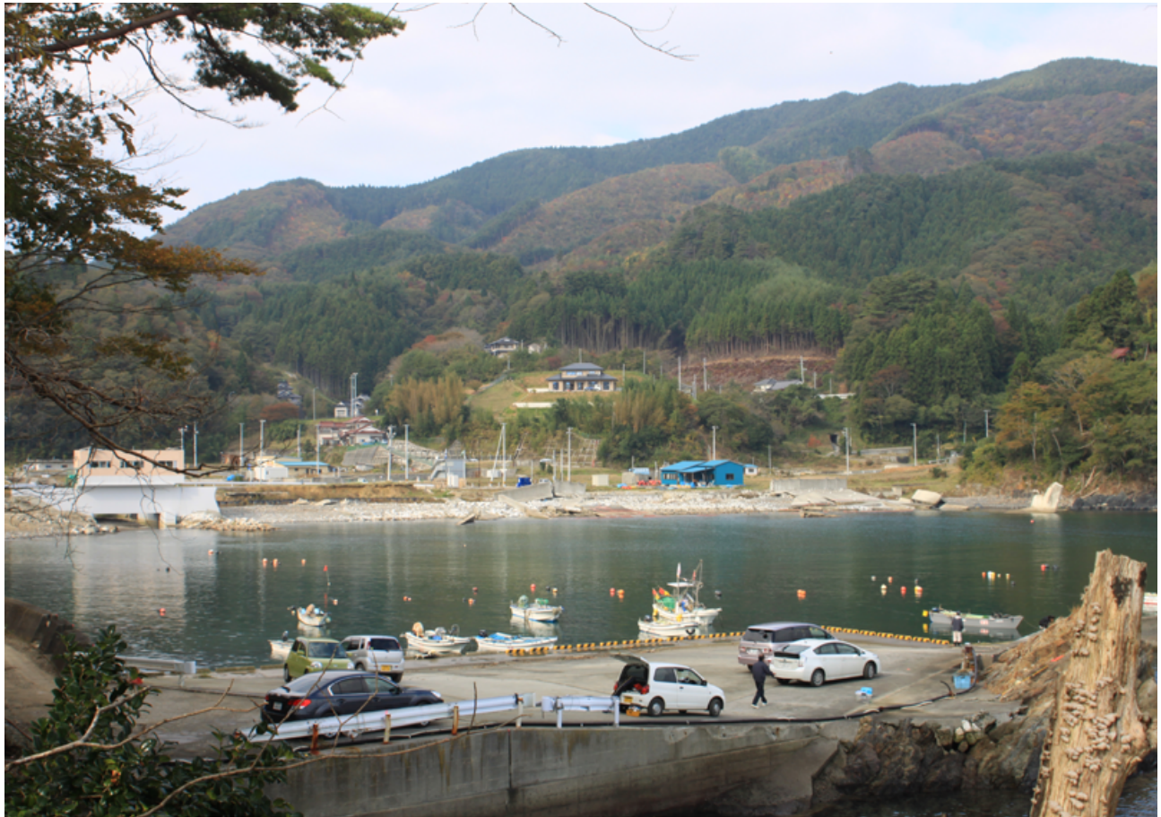
図1 気仙沼の只越地区。兩岸あわせて90メートル、高さ11.3メートルの防潮堤が造られる
